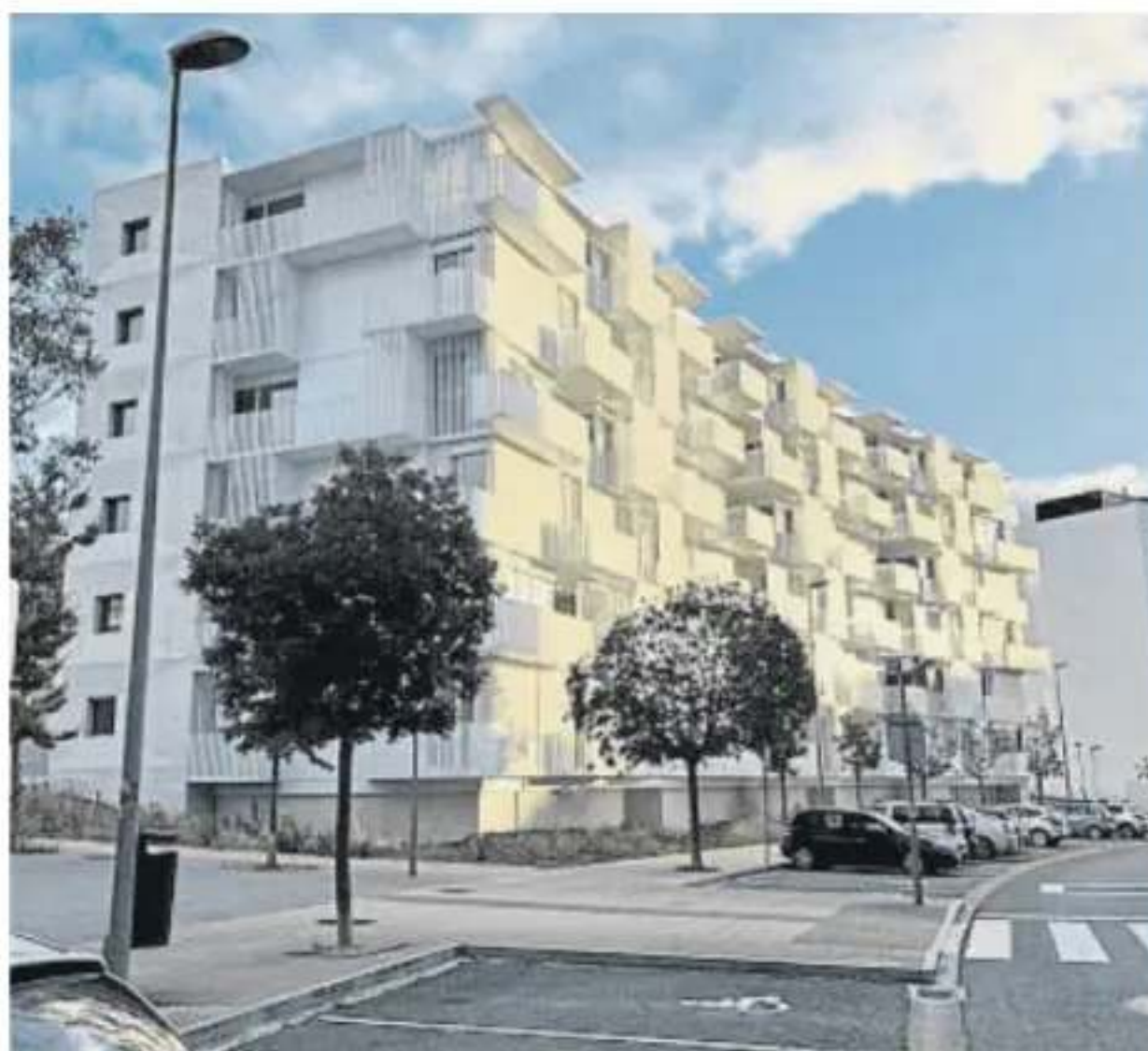
Imagen del edificio de viviendas de Ripagaina
